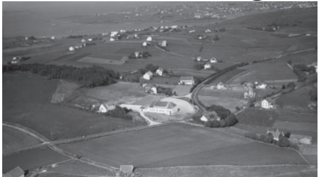
Mye har forandret seg på Tasta siden dette bildet ble tatt på 1950-tallet. Og større vil forandringene bli om planene for E39 Eiganestunnelen blir realisert. Foto: Byarkivet i Stavanger/ Widerøe.
