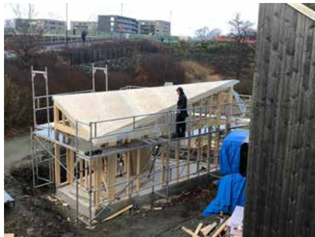
Bygging av lagerbod startet høsten 2022 og ble tatt i bruk i 2023. Foto: Erik Thoring
