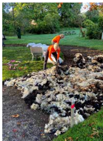
I stedet for plastduk er det brukt kassert saueull som underlag for grusgangen i pollinatorhagen. Ansatte i NATUREco i arbeid. Foto: Erik Thoring
